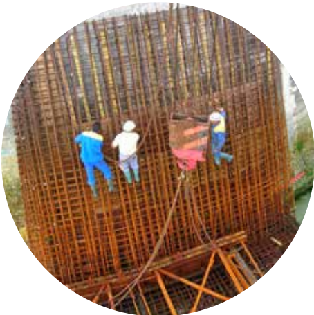
Les travaux étaient réalisés « à sec » à marée basse comme le montre la mise en place de la cage d'armature de 2 plots.
