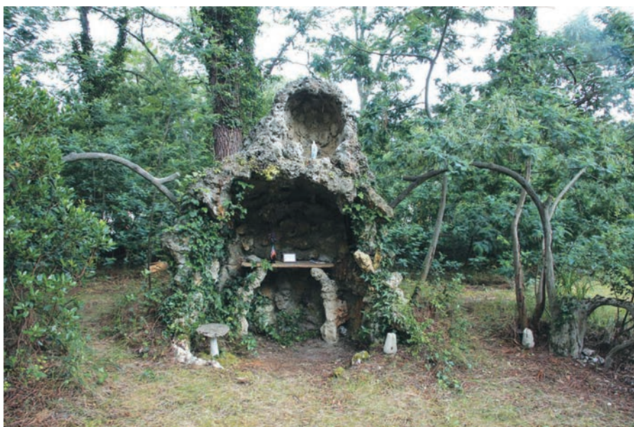
Avec le temps les arches de chaque côté du bâti et la clôture en ciment armé décoré imitation de branches d'arbres se confondent parfaitement avec le bois naturel des mimosas et acacias.
