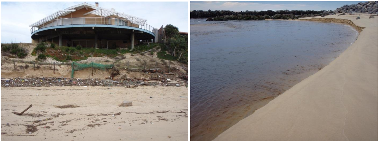
Figure 44 - Érosion des berges au sein du courant (Contis, 08/01/2014, BRGM).
