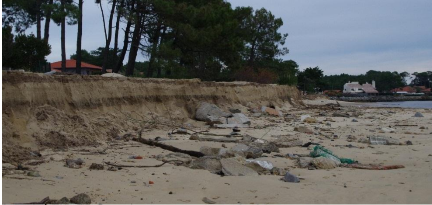
Figure 39 - Érosion des berges en amont du courant (Mimizan, 08/01/2014, BRGM).
