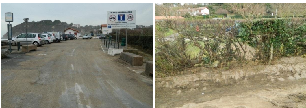
Figure 108 - Dépôt de sable à la suite de la submersion du parking d'Erromardie et des campings en arrière (Saint-Jean-de-Luz, 09/01/2014, BRGM).
