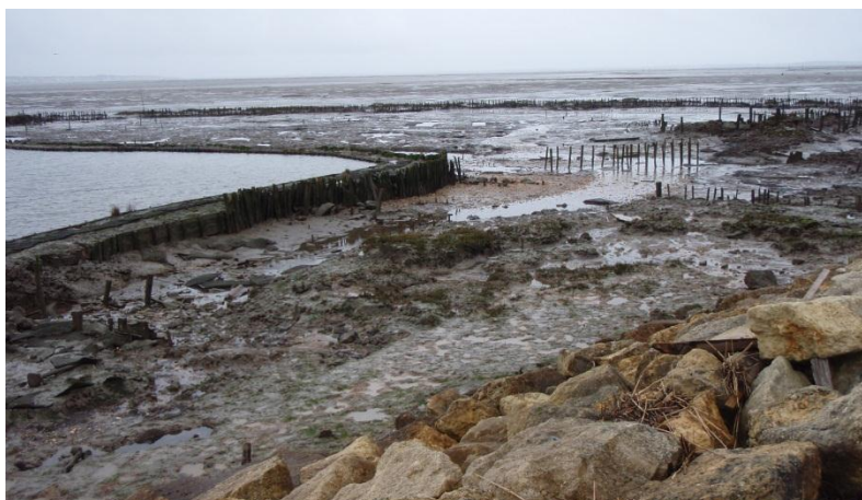
Figure 75 - Érosion du schorre sur le domaine de Certes (Audenge, 23/01/2014, BRGM).
