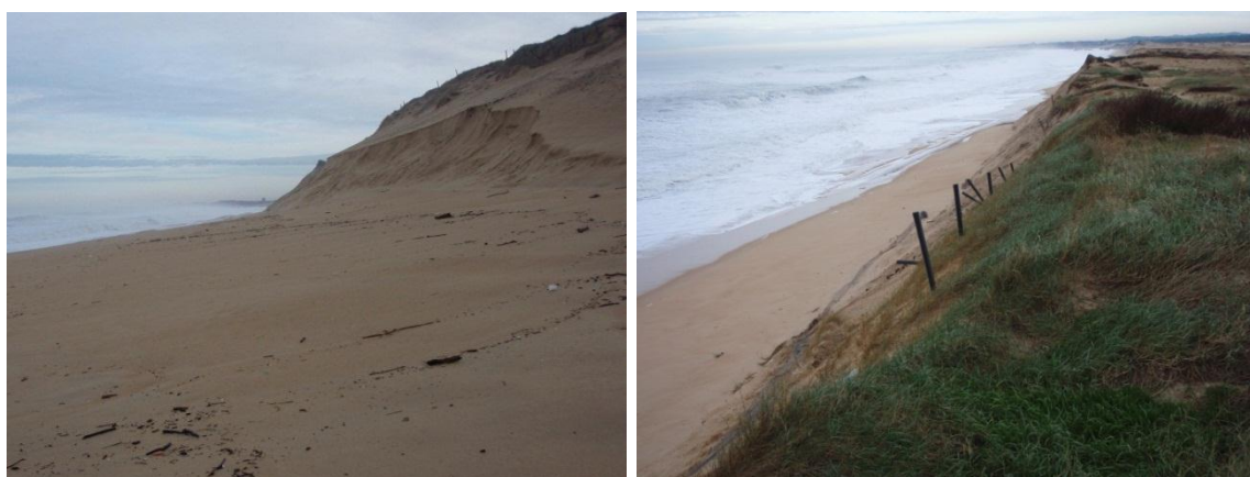
Figure 53 - Gauche : entaille d'érosion marine sur la Plage de la Pointe, visible à partir de la station d'épuration ; Droite : destruction de l'ouvrage géotextile longitudinal la Plage de la Pointe, initialement en pied de dune (Capbreton, 08/01/2014, BRGM).
