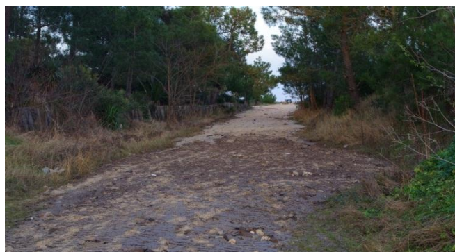
Figure 69 - Submersion locale dans le domaine des 44 Hectares avec dépôt de sable et de vase (Lège-Cap-Ferret, 09/01/2014, BRGM).
