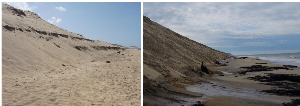
Figure 29 - Érosion du pied de dune et de la plage, apparition du paléosol, à gauche : avril 2013, à droite : janvier 2014 (08/01/2014, BRGM,).
