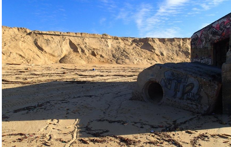
Figure 56 – Entaille d'érosion dunaire au droit du blockhaus (Ondres, 21/01/2014, BRGM).
