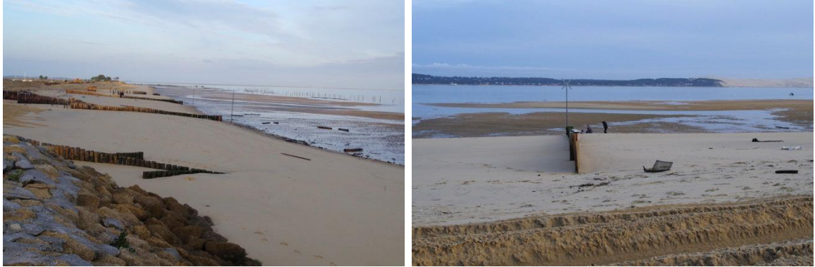
Figure 65 - Plage du Mimbeau, pas d'érosion généralisée de la plage (Lège-Cap-Ferret, 09/01/2014, BRGM).
