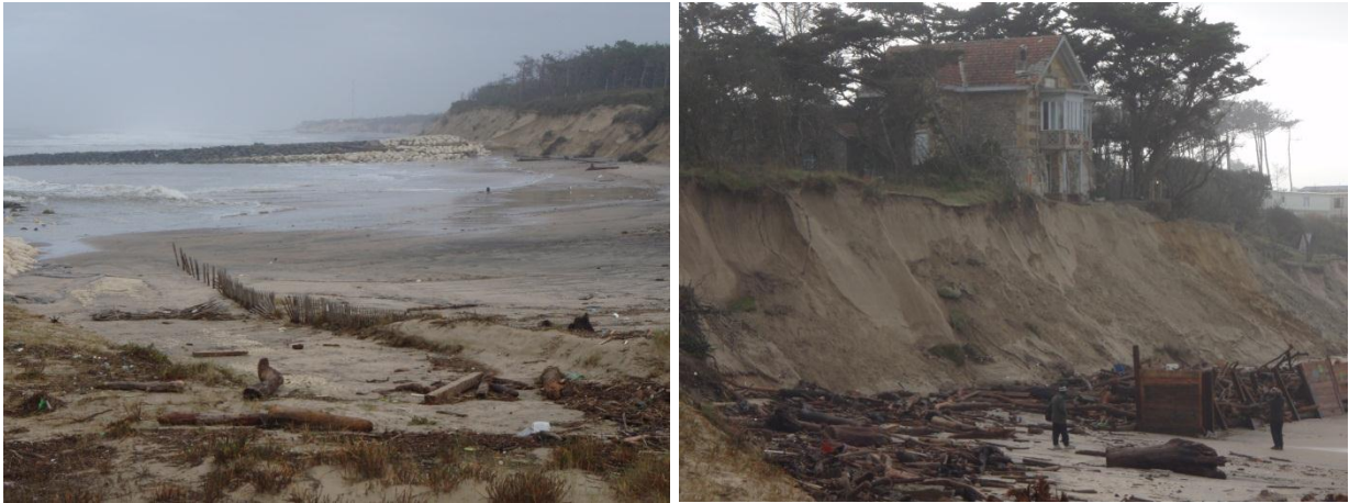
Figure 11 - Gauche : falaise continue jusqu'au camping au Nord des ouvrages ; Droite : érosion du cordon dunaire au droit de la Villa « Surprise » à l'Amélie (Soulac-sur-Mer, 07/01/2014, BRGM).
