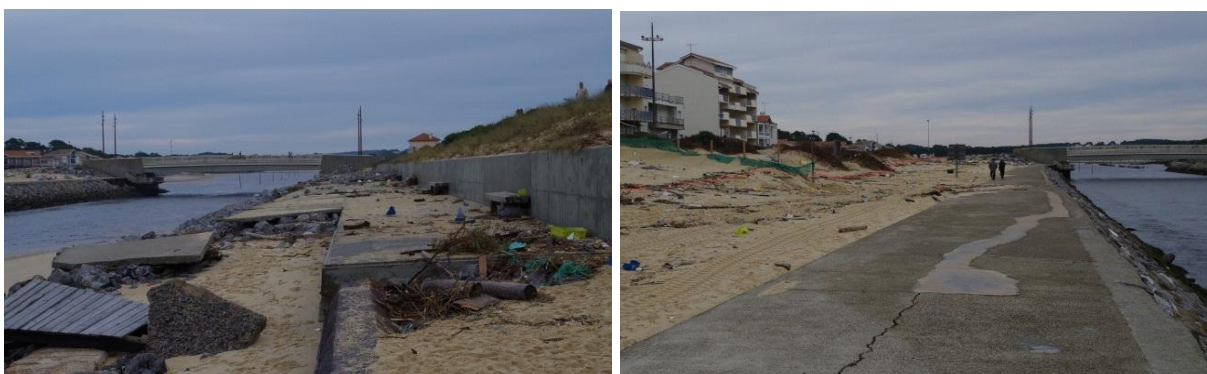
Figure 37 - Surverse des ouvrages, dépôt de débris et déplacement de blocs (Mimizan, 08/01/2014, BRGM).
