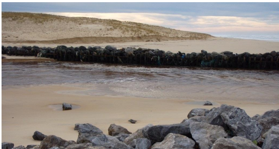
Figure 45 - Érosion de la dune directement au Sud du courant (Contis, 08/01/2014, BRGM).
