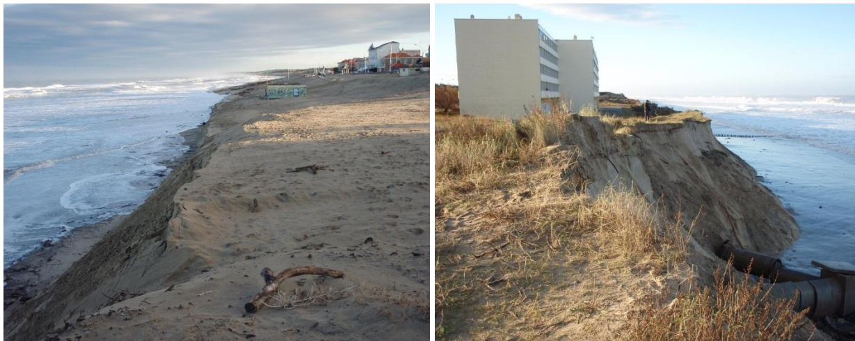
Figure 9 - Gauche : recul du front de mer au Nord de l'immeuble Le Signal ; Droite : érosion majeure au droit du Signal, séparé du haut de falaise par 15 m de dune (Soulac-sur-Mer, 07/01/2014, BRGM).
