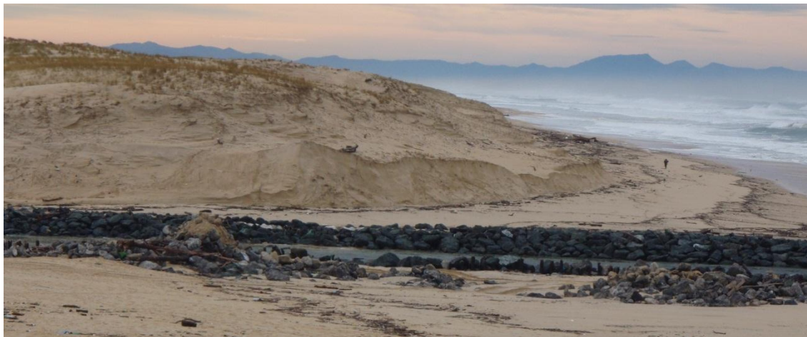
Figure 49 - Érosion de la dune directement au Sud du courant (Soustons, 08/01/2014, BRGM).
