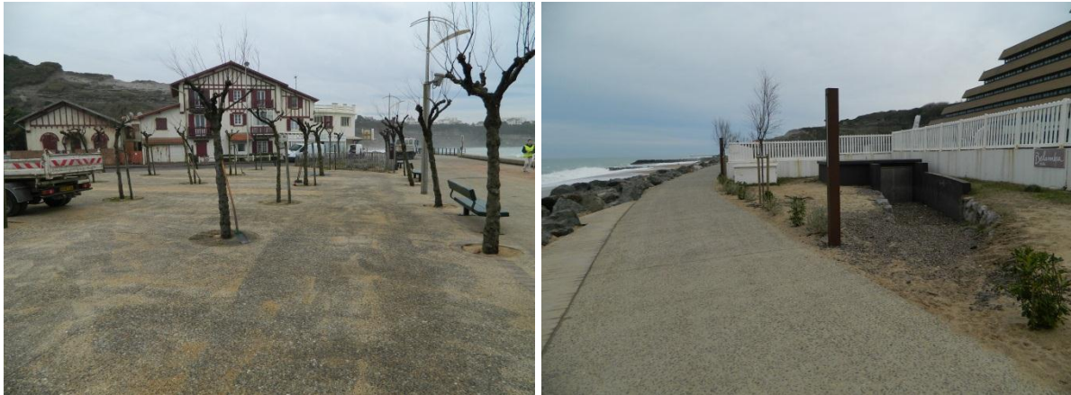
Figure 82 - Gauche : submersion du parking de l'Avenue des Vagues ; Droite : submersion de la promenade de La Chambre d'Amour jusqu'au pied du mur du Belambra (Anglet, 09/01/2014, BRGM).
