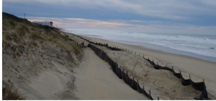
Figure 34 - Protections mises en place par la commune sur la Plage centrale (Biscarrosse, 08/01/2014, BRGM).
