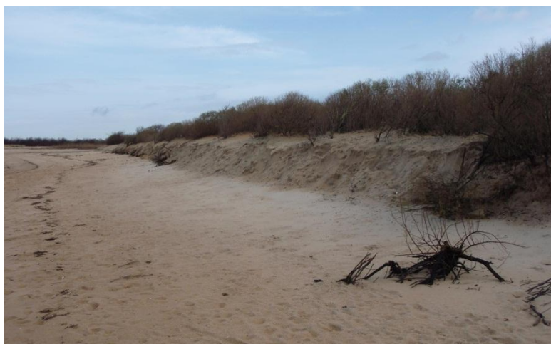
Figure 77 – Érosion du pied de digue et déracinement de Tamaris sur le secteur du Parc Ornithologique (Le Teich, 23/01/2014, BRGM).
