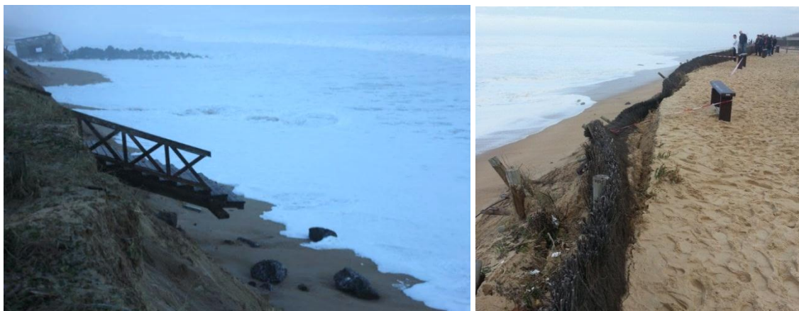
Figure 55 – Gauche : destruction de l'accès de plage dans la nuit du 6 au 7 janvier 2014 ; Droite : érosion et affaissement du sommet de falaise (Ondres, 07/01/2014, Commune d'Ondres).
