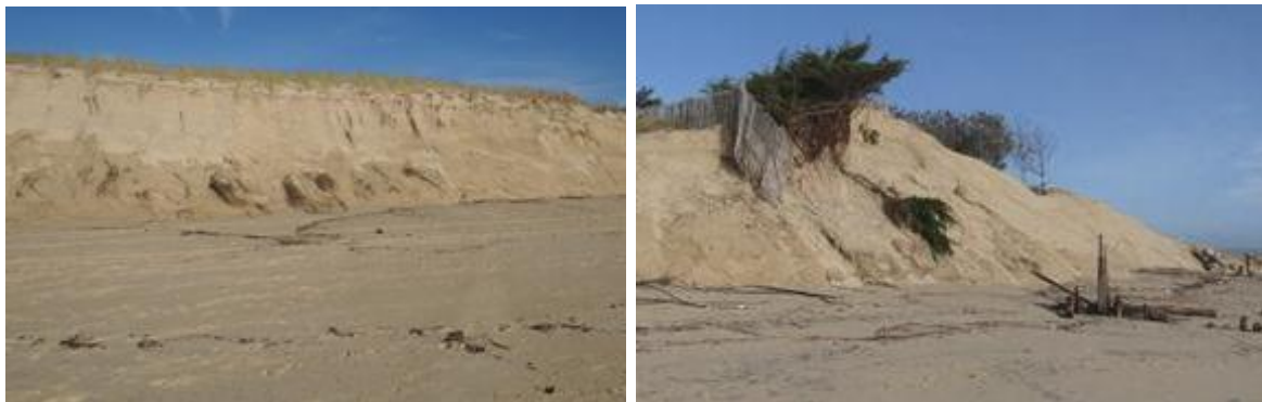
Figure 21 - Gauche : érosion au Sud du village « des blockhaus » ; Droite : érosion au niveau de la Pointe du Cap Ferret (Lège Cap Ferret, 07/01/2014, ONF).
