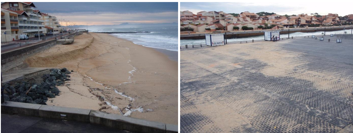
Figure 50 - Gauche : érosion de la Plage centrale ; Droite : submersion et dépôt de sable sur la promenade de la jetée Sud (Capbreton, 08/01/2014, BRGM).
