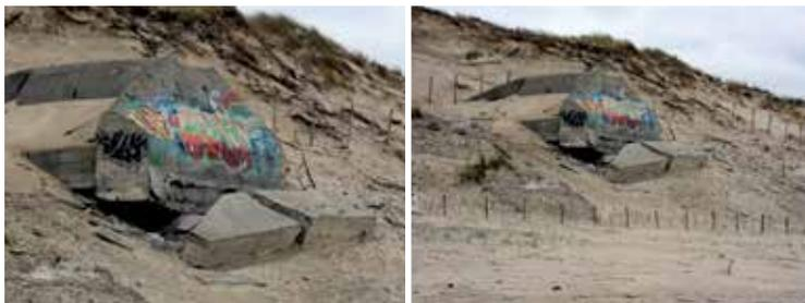
La structure de béton très dur avec armatures d'acier inoxydable semblait assurer à ces constructions une durée de vie de plusieurs centaines d'années.
