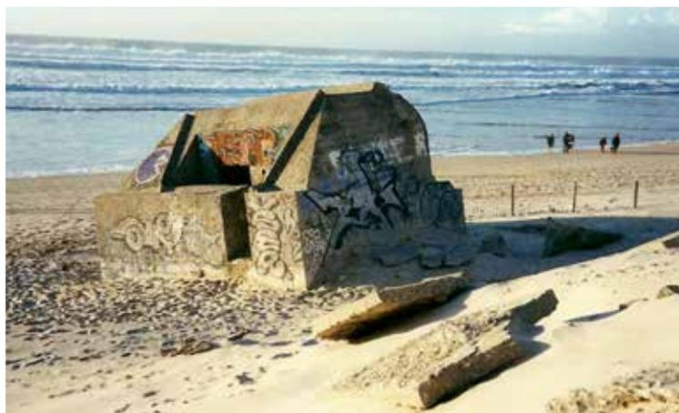
De la démolition sont restés quelques blocs de béton et des ferrailles enfouis dans le sable, posés sur la croûte d'aliôs.
